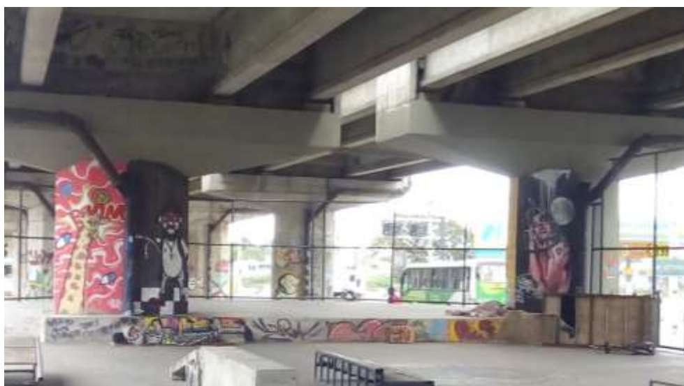
Figura 04: Pessoas dormindo dentro da quadra de esportes embaixo da ponte Leonel Brizola. Fonte: Trabalho de campo realizado em 22/08/2017
