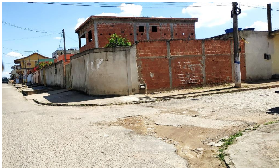
Figura 18: Esquina em péssimo estado de manutenção no Bairro Jardim Aeroporto
