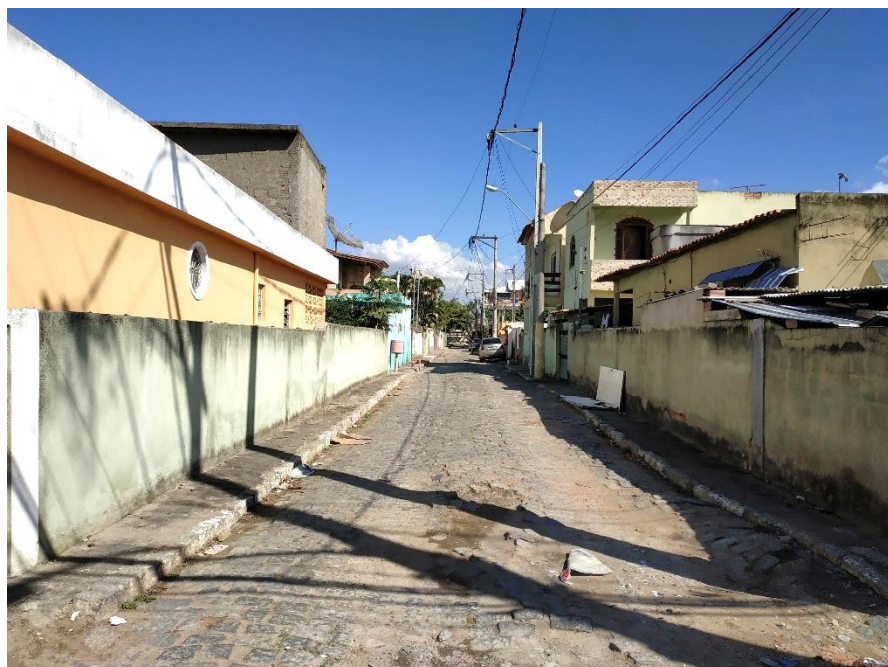
Figura 23: Parque Aurora – Construções sem recuo frontal, sem garagem e com calçadas extremamente estreitas.
