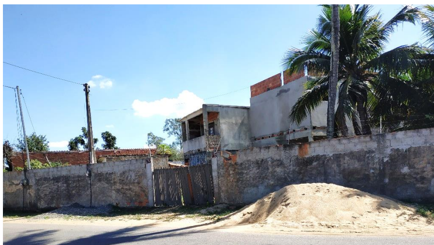
Figura 19: Construção residencial de dois pavimentos inacabada no Jardim Aeroporto com construção iniciando no terceiro pavimento.
