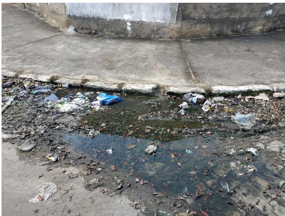
Figura 24: Água e lixo acumulados no Bairro Parque Prazeres
