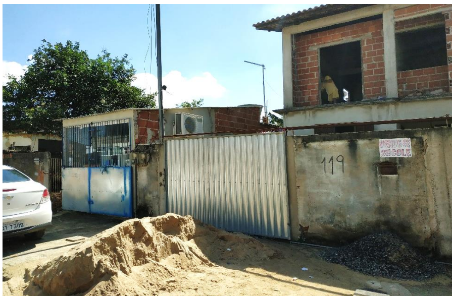
Figura 21: Areia, brita e carro obstruindo circulação da calçada do Bairro Parque Guarus
